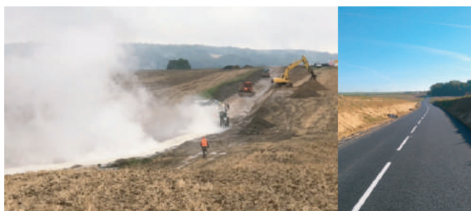
Les travaux ont été effectués par l'entreprise COLAS, titulaire du marché pour un coût de 380 000 € TTC
