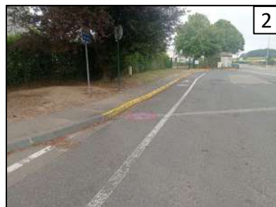
Accès du collège facilité pour les piétons
