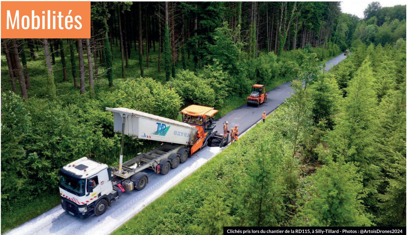
Clichés pris lors du chantier de la RD115, à Silly-Tillard - Photos : @ArtoisDrones2024
